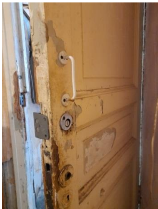
Дверь: ошкуливание, шпаклевка, окраска
