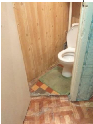
Туалет: установка стенных и потолочных панелей, настил линолеума
