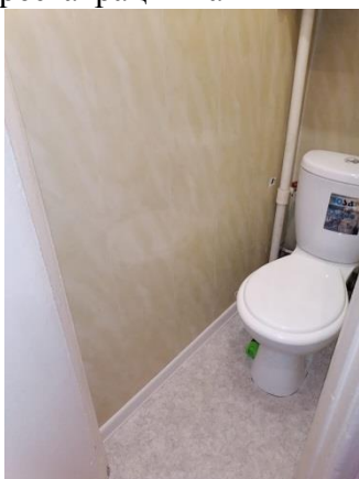
Туалет: установка стенных и потолочных панелей, настил линолеума
