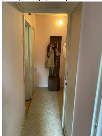
Коридор: окраска потолка, оклейка стен, настил линолеума
