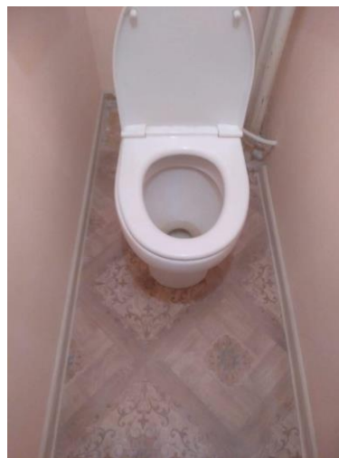
Туалет: стены, потолок, новый линолеум
