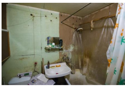
Ванная до ремонта
